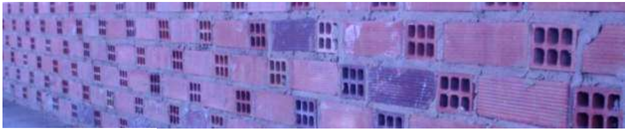
Muro de bloques Cal NHL 5
