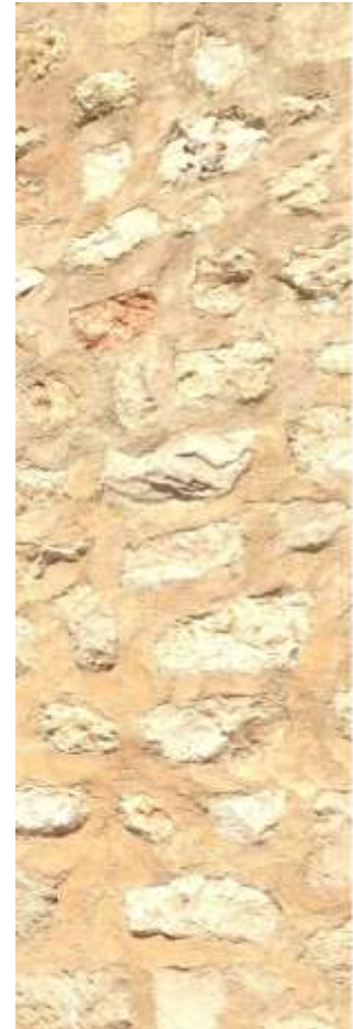
Rejuntado Cal NHL 3.5
