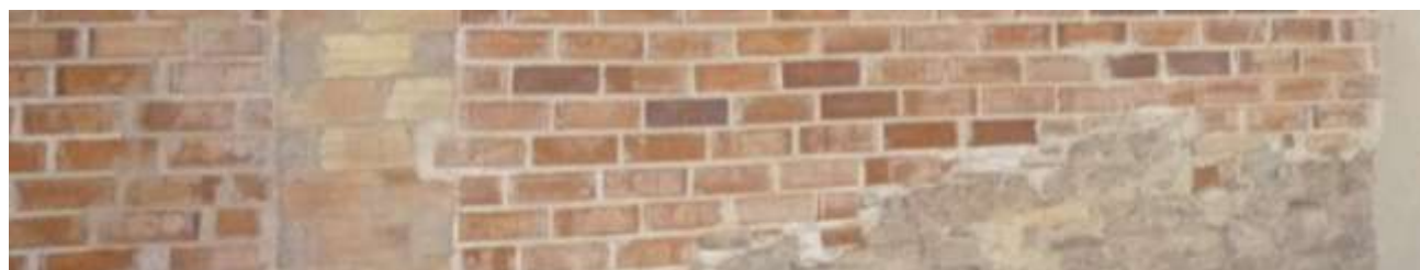
Muro Cal NHL 5 listo para recubrir
