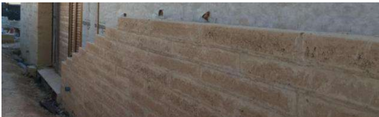
Muro bloque de arcilla estabilizada con Cal NHL 5 (SEGUR DE CALAFELL)
