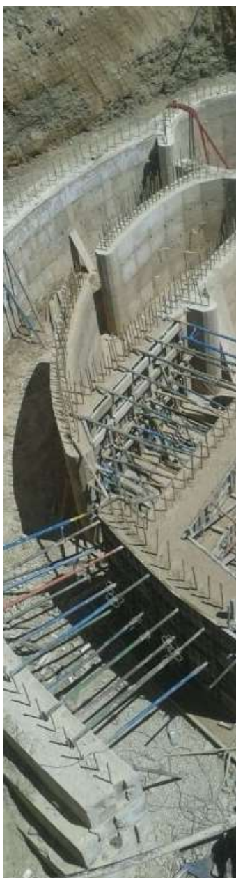
Muros con hormigón de Cal NHL 5 en la construcción de una bodega.
