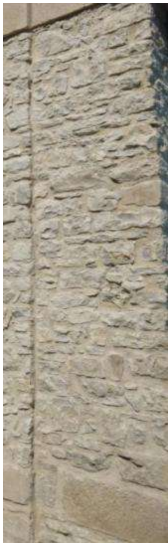
Muro piedra Cal NHL 5
