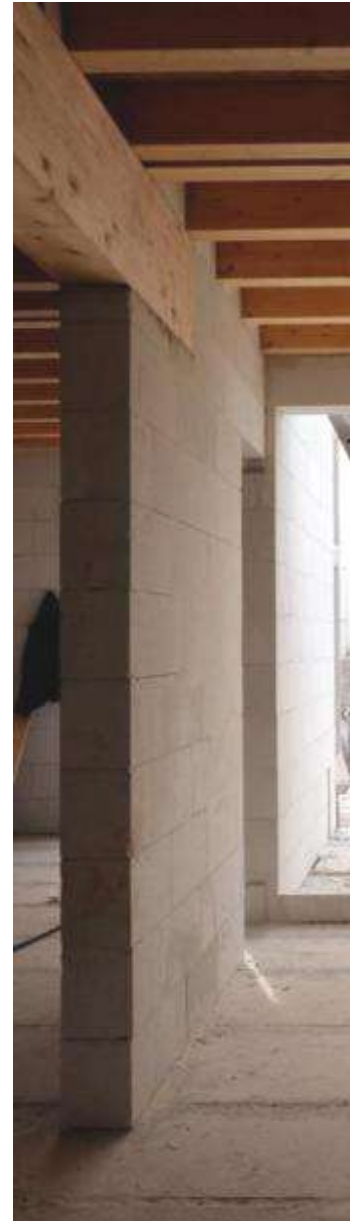
Solera de cal NHL-5 Muro levantado con mortero de cal NHL-5
