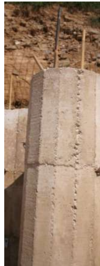
Detalle muro hormigón de Cal NHL 5 con armado de bambú
